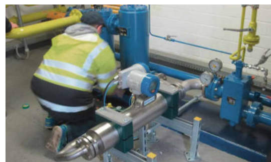
Система для заправки танкеров сжиженным газом, соответствующая требованиям MID MI-005
